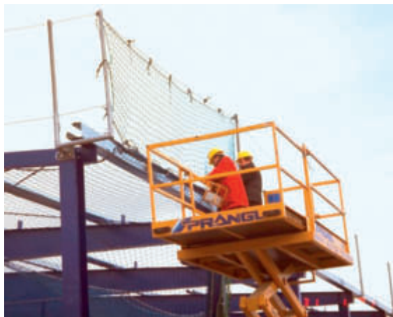
Montage des Auffangnetzes samt Dachrandsicherung
