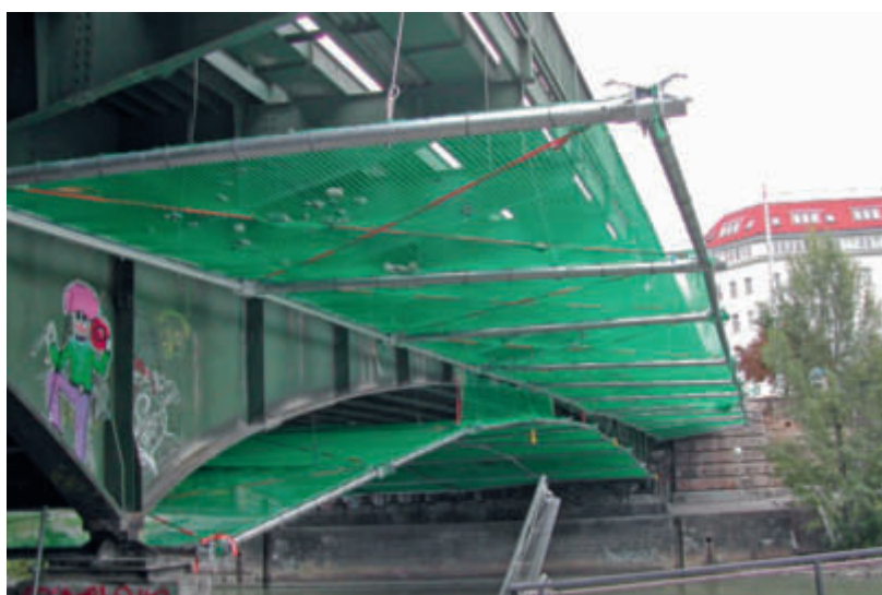
Arbeitsplattformnetz unter der Friedensbrücke in Wien (im Bau)
