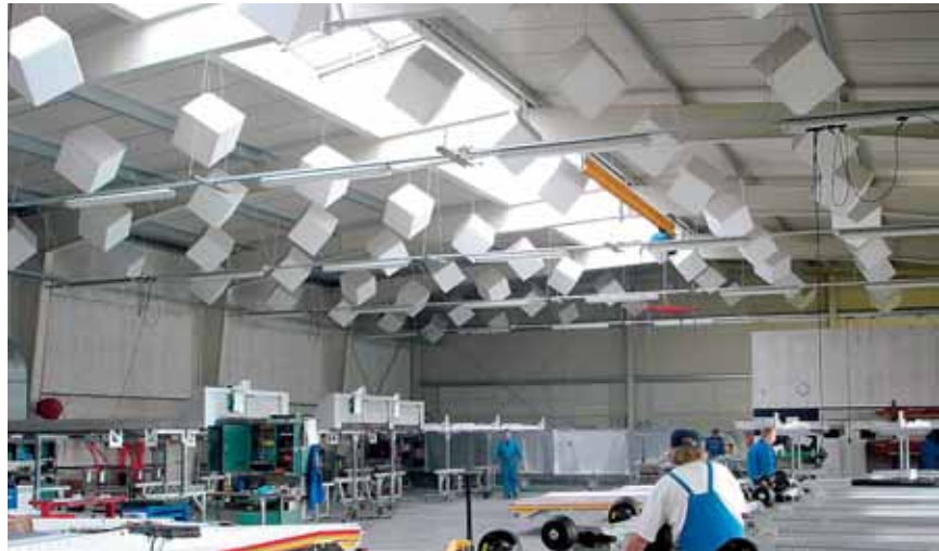
Absorberwürfel an der Decke sorgen für eine erhebliche Schallreduktion
