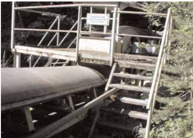
Abb. 3: Sicherer Verkehrsweg über ein Förderband
