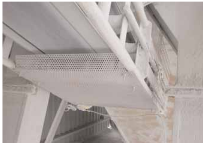
Abb. 4: Schutzblech unterhalb eines Förderbandes zur Sicherung des darunter kreuzenden Verkehrsweges
