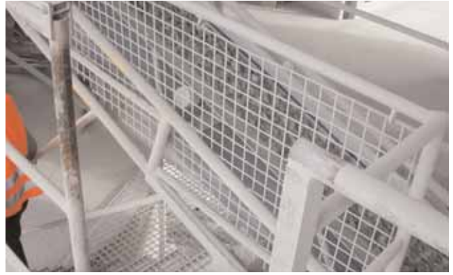
Abb. 2: Einfache Sicherung von Tragrollen an einer vorbeiführenden Stiege mittels Schutzgitter
