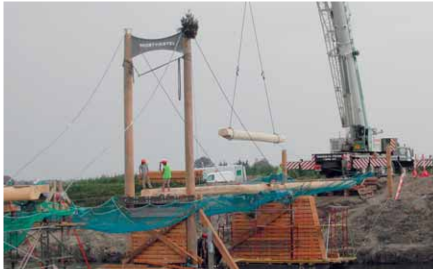
Vorhandene Sicherheitsmaßnahmen werden dann häufig umgangen, wenn sie die Arbeit behindern bzw. deutlich erschweren
