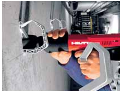
Abb. 4: Befestigung von Kabeln mittels Direktbefestigung
