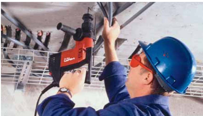
Abb. 3: Befestigung von Kabeln mittels Bohrhammer und Dübel
