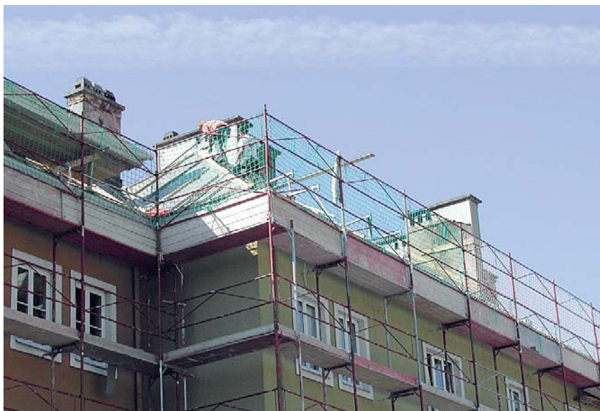
Sicheres Arbeiten auf dem Dach
