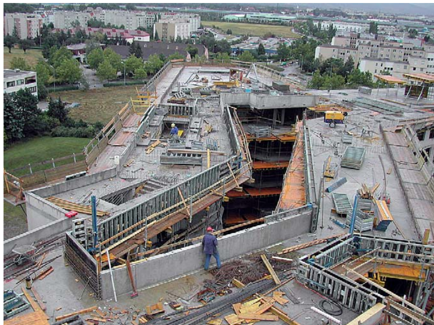
Eine gute Absturzsicherung schützt nicht vor allem. Wo viel herumliegt, besteht die Gefahr, zu stolpern und sich so mitunter ernst zu verletzen
