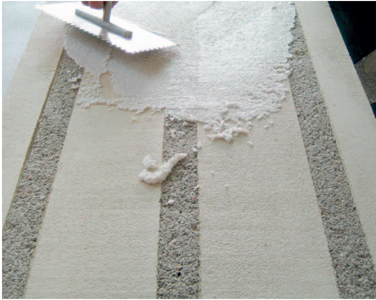
Prototyp des neuartigen Schlitzabsorbers
