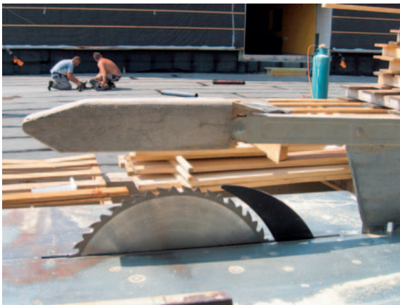
Abbildung 3: Elegant rustikale minimale Schutzhauben-Nachrüstung einer Baukreissäge auf einer Großbaustelle.
