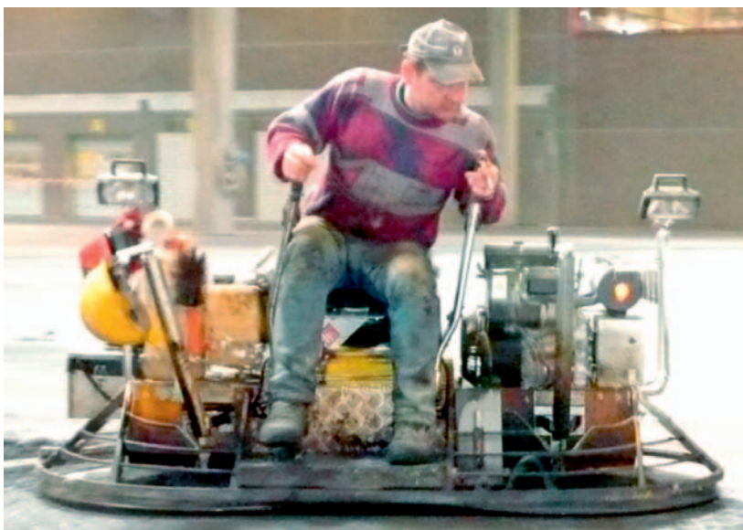
Abbildung 3: Doppelflügelglätter mit Katalysator (durch die Verbrennung des CO zu CO 2 glüht das Innere des Kat)
