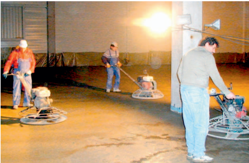
Abbildung 1: Drei Einfachglätter im Betrieb
