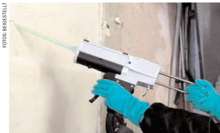
Abbildung 1: Pistole zum Mischen eines Zweikomponenten-PUR-Produktes
