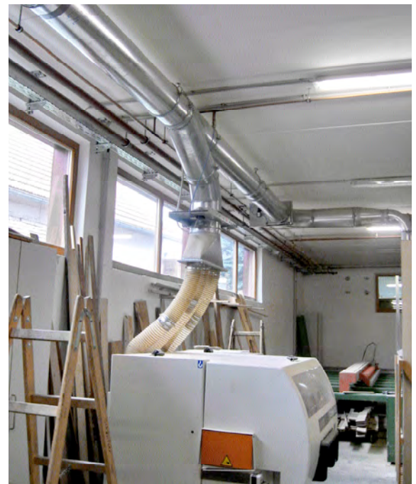
Übergangsstück mit Schieber zum Anschluss von drei Absaugschläuchen an eine gemeinsame Saugleitung
