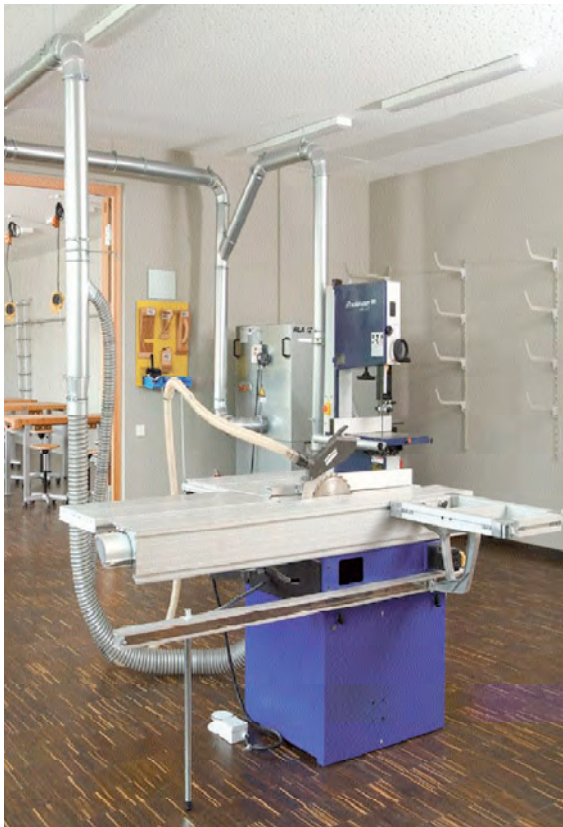
Beispielhaft verlegte Absaugleitungen an Formatkreissägemaschine und Bandsägemaschine
