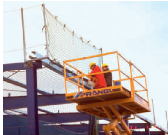
Montage des Auffangnetzes samt Dachrandsicherung
