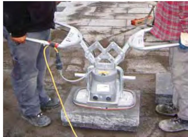
Steinplattenverlegung mit Handvakuumsauger
