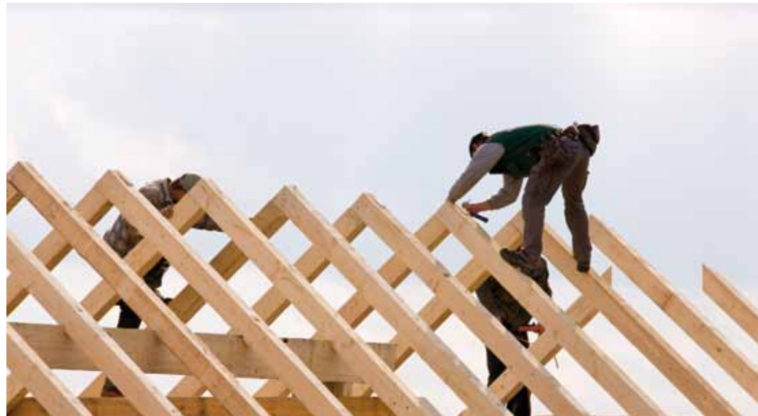
Zur Planung gehört auch die richtige Absturzsicherung
