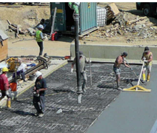
Datenerhebung auf der Baustelle (Betonierarbeiten mit Herzfrequenzaufzeichnung)
