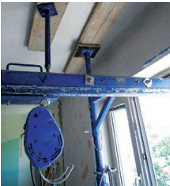
Der adaptierte Lastenaufzug hilft Belastungen zu reduzieren
