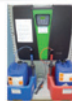
Abb.: Chlordioxidmietanlage
