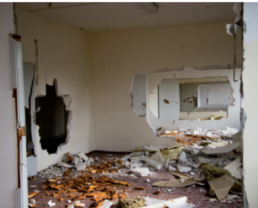
Oft müssen Tonnen von Bauschutt abtransportiert werden
