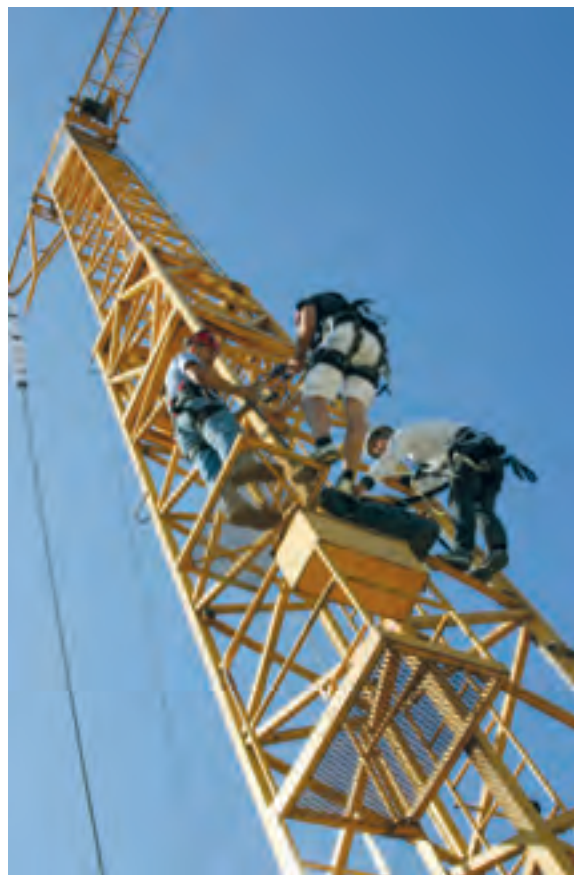
Hauptthemen der Fortbildung waren Arbeiten mit Anseilschutz und die Durchführung einer Rettungsübung
