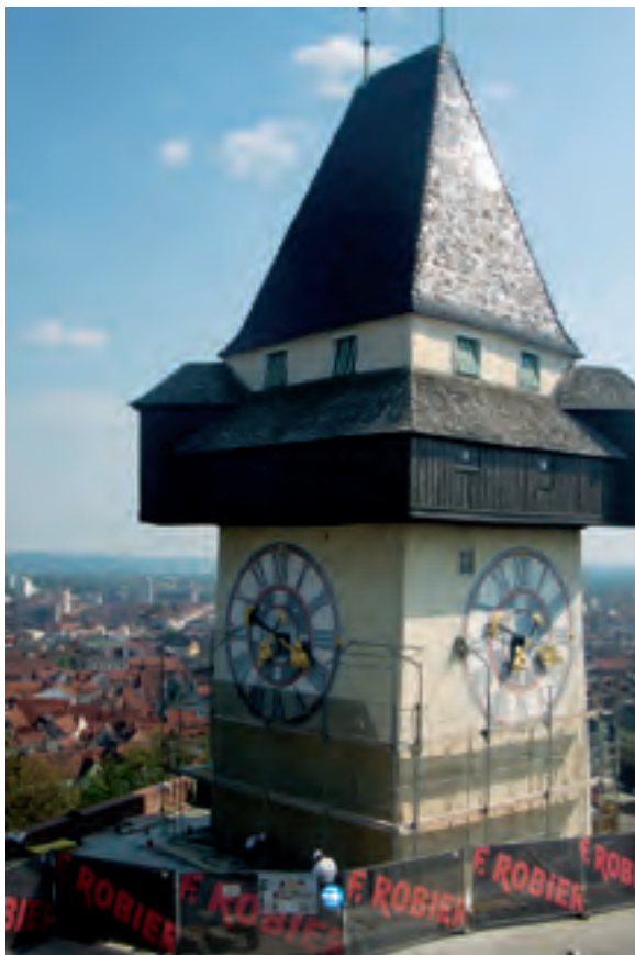
Ein Prestigeprojekt von F. Robier war 2011 die Fassadensanierung des Grazer Uhrturms
