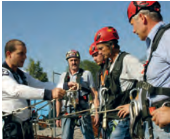
Persönliche Schutzausrüstung und Auffanggurt sind als Schutz gegen Absturz unumgänglich
