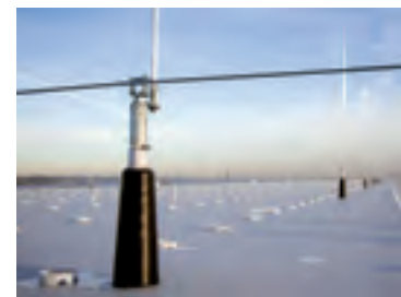
Seilsicherungssystem mit integriertem Blitzschutz
