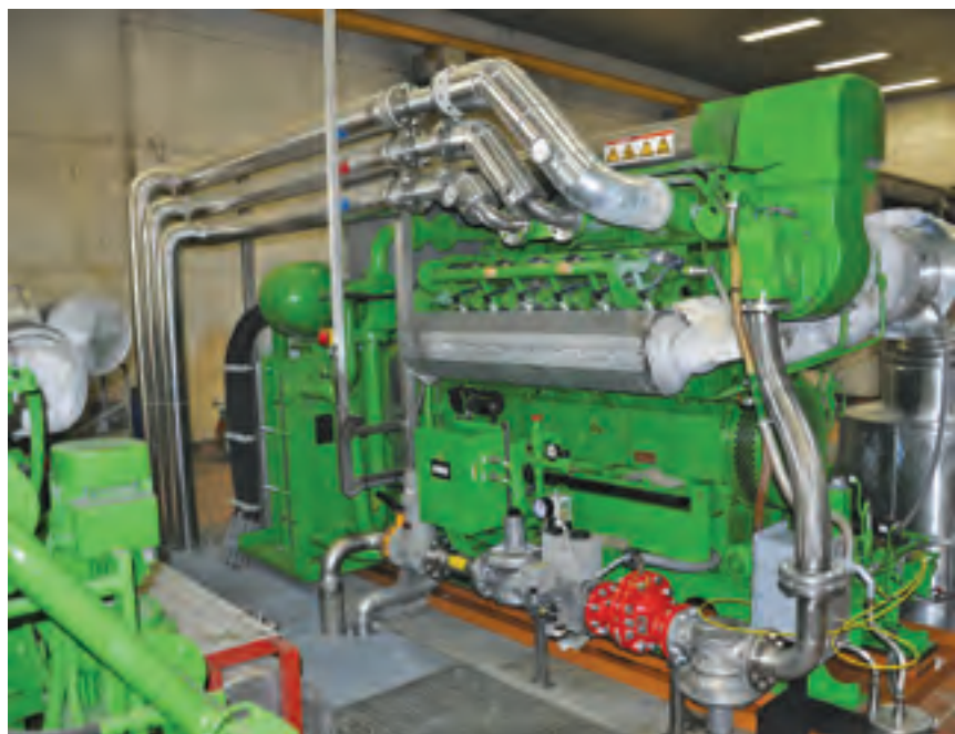
Jährlich erzeugt der Abwasserverband AIZ 4,5 Millionen kWh elektrischer Energie
