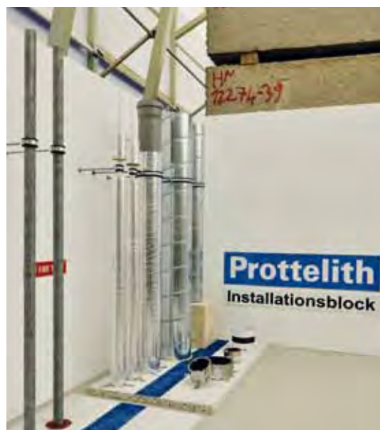
Der Prottelith Installationsblock erhöht die Sicherheit in der Bauphase und bietet nach Fertigstellung des Gebäudes eine effektive Brandabschottung.
