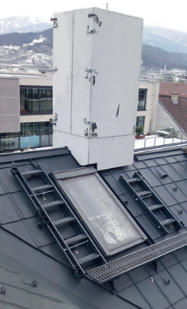
Seit Einführung dieser Sicherheitsmaßnahme hat sich bei Perktold am Dach kein einziger Arbeitsunfall durch Sturz und Fall ereignet.
