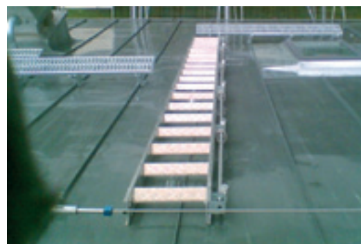
Dank der fixen Montage ist hohe Trittsicherheit ohne seitliches Verrutschen möglich.
