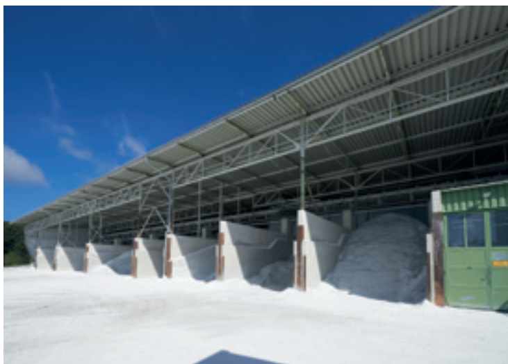
„SAFE START“ hat dazu beigetragen, dass man bei Imerys in den vergangenen fünf Jahren keinen Arbeitsunfall verzeichnete.
