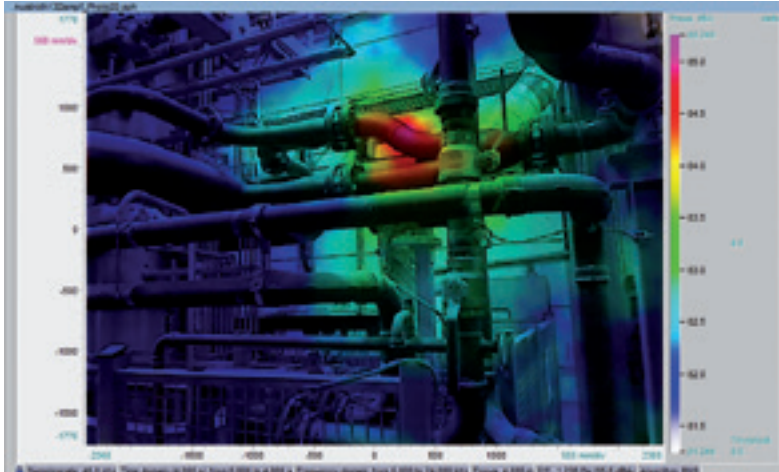
Akustisches Foto einer Dampfzuleitung: Das Ventil ist aufgrund der höheren Lärmentwicklung im Vergleich zur Leitung als Hauptlärmquelle deutlich erkennbar
