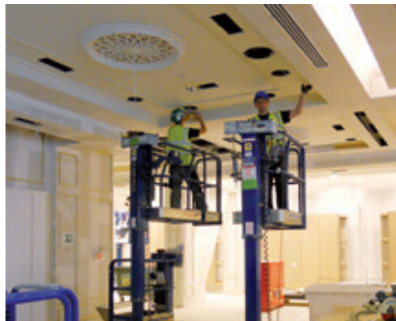
Selbstfahrende Hubarbeitsbühnen werden elektromotorisch angetrieben.
