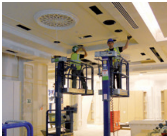
Selbstfahrende Hubarbeitsbühnen werden elektromotorisch angetrieben.
