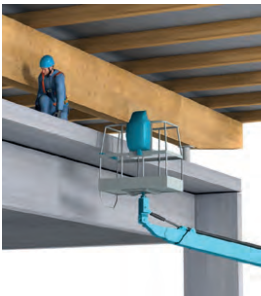
Strikt verboten ist es, auf das Geländer des Arbeitskorbes zu steigen oder gar die Bühne in der Höhe zu verlassen.
