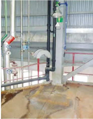
Durch die Schaffung von Ringleitungen und den Anschluss weiterer Verbraucher kann Stagnationswasser verhindert werden.
