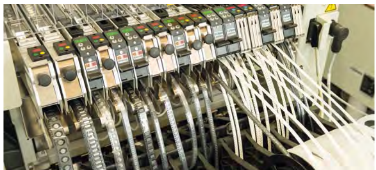
LOYTEC hat sich auf intelligente Netzwerkinfrastrukturprodukte und Automationslösungen für die Gebäudeautomation spezialisiert.
