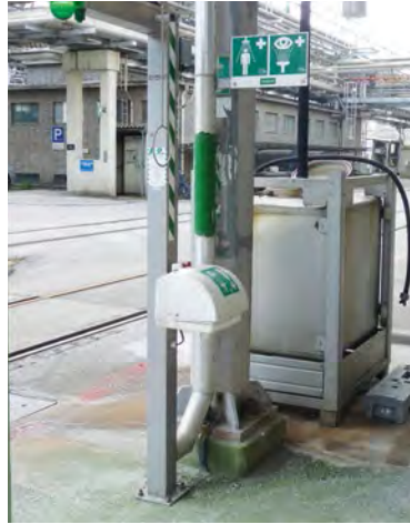
Eine einmalige chemische Desinfektion des Notduschensystems ist vergleichsweise aufwendig.
