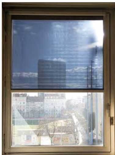
Foto 1: Beispiel einer halbdurchlässigen Lichtschutzfolie, als Rollo ausgeführt: Sie verhindert Blendung durch Tageslicht, lässt aber dennoch die Sicht ins Freie zu.
