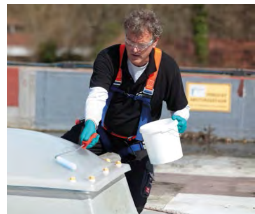
Mehr Sicherheit: Kemperol Fallstop besitzt die geprüfte Durchsturzsicherheit nach GS BAU 18. Das Beschichtungssystem auf Polyurethanbasis ist einkomponentig und gebrauchsfertig und wird gleichmäßig und blasenfrei mit der Schaumstoffrolle im Kreuzgang verarbeitet.
