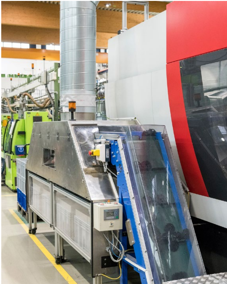
Beispiel für eine Absaugungslösung im Kunststoffspritzguss: Die Auswurfseite der Maschine und die Transportboxen mit frischen Formteilen, die Formaldehyd ausdampfen, sind eingehaust und werden abgesaugt
