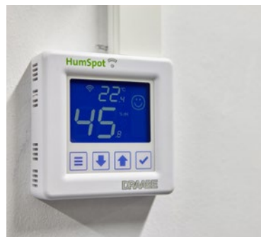
Die digitale Steuerung HumSpot regelt konstant 45 Prozent relative Feuchte
