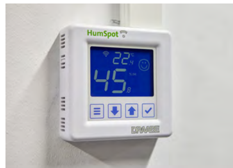
Digitale Steuergeräte regeln die Luftfeuchte auf mindestens 40 Prozent.
