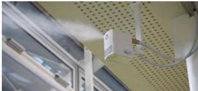
Direkt-Raumluftbefeuchter sichern bei seele eine optimale Luftfeuchte von 45 %.
