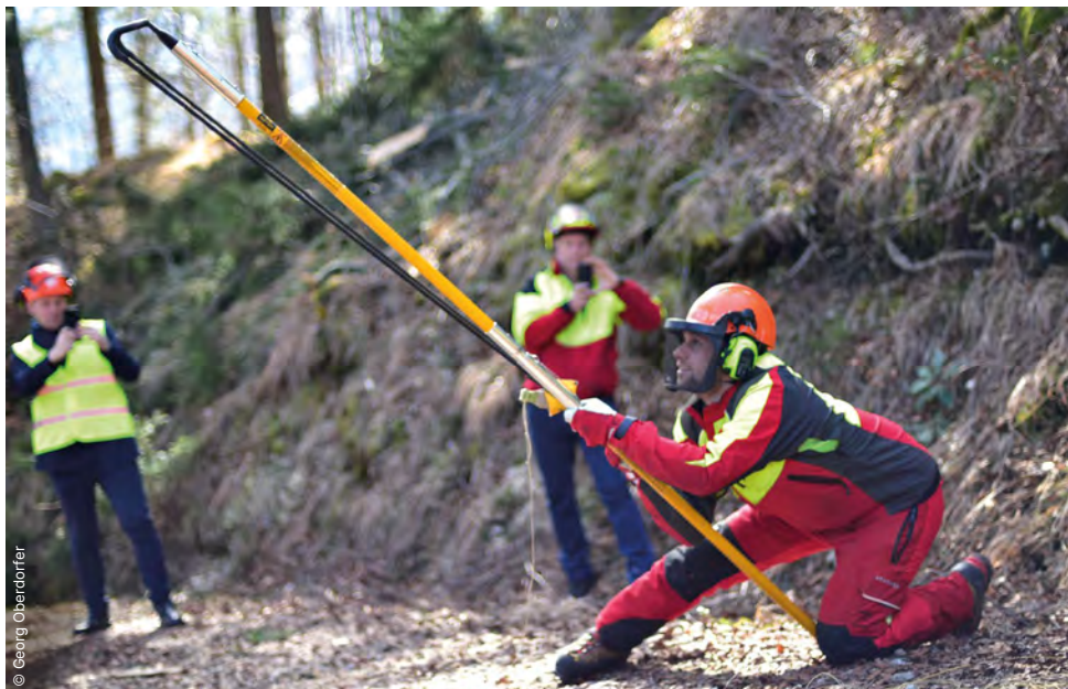
Der Seileinbau nach der Darmstädter Seilzugtechnik erfolgt mithilfe einer Schleuder mit Wurfbeute, die das Einziehen von Seilen effizient und sicher über größere Distanzen ermöglicht
